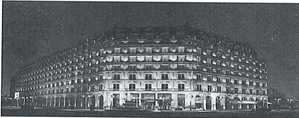
Hình 7: Dự án số 10 Trần Nguyên Hãn
