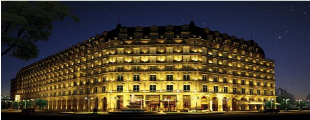
Hình 10: Dự án số 10 Trần Nguyên Hãn
